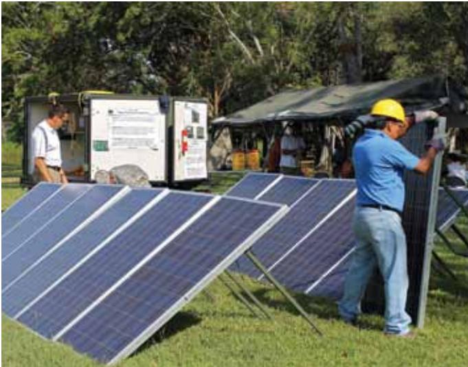
**El equipo técnico de PEAK instaló 12 paneles solares con la capacidad de generar 2,2 Kw diarios.**
